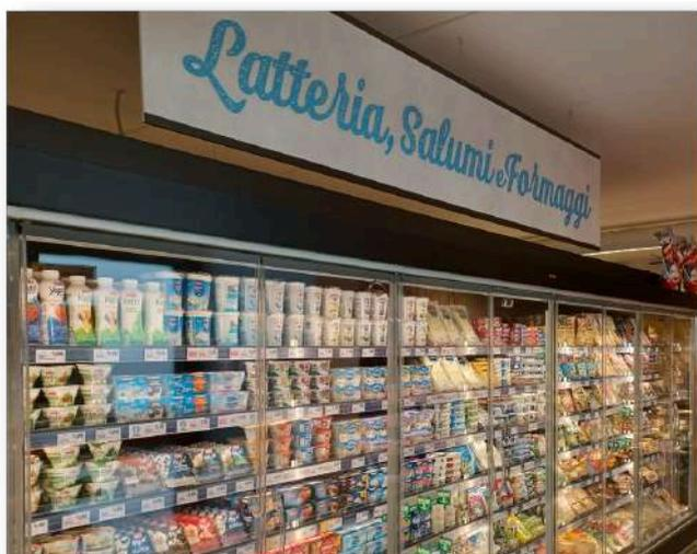
In particolare, i vecchi impianti refrigeranti a gas freon vengono sostituiti o riconvertiti con dei nuovi dispositivi utilizzando miscele di gas meno inquinanti o CO2. Inoltre, si preferisce installare banchi frigo con porte che garantiscono, oltre ad un notevole risparmio energetico, una conservazione migliore del prodotto.
